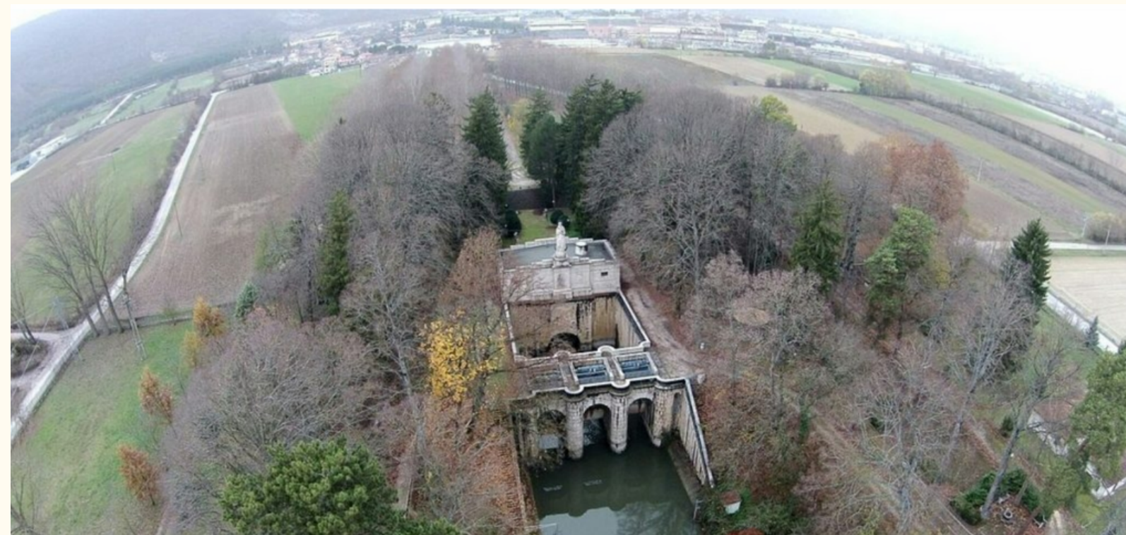
Struttura per la bonifica del lago Fucino intrapresa dall'Imperatore Claudio e realizzata da Alessandro Torlonia (1855-1878)
