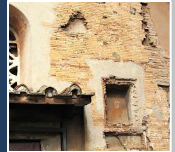
Particolare della facciata principale
