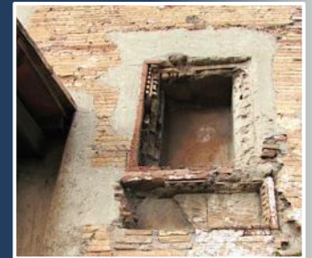
La copertura originale del muro in cortina di epoca romana
