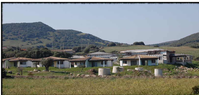
Costruzione ad uso alberghiero, iniziata con fondi regionali, nei pressi del complesso nuragico di Corongiu Murvonis. L’iniziale cartello con indicazione della licenza edilizia portava la dicitura “CENTRO di RISTORO”
