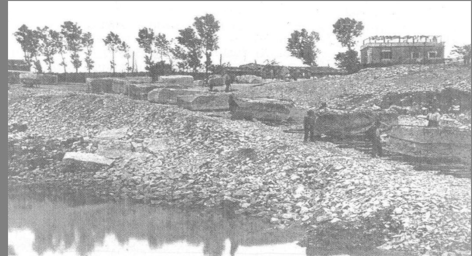
Trasporto dei blocchi su lizze di pali per essere imbarcati e trasportati a Roma, via Fiume Aniene su zattere di legno
